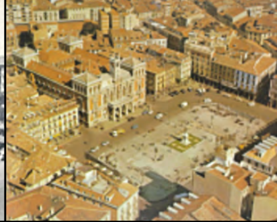
Plaza Mayor con el aparcamiento terminado y abierta al tráfico.
